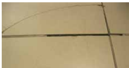
Obr. 3: Čím menší velikosti dlaždic, tím větší je počet dlaždic a spár, které přicházejí do styku s dráhou koleček. Obrázek ukazuje příklad „poškozených dlaždic“ a „vypadlé“ malty ze spár.
