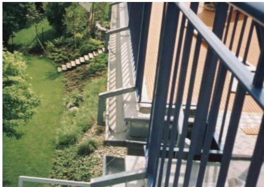
Optimální řešení ukotvení zábradlí mimo dlažbu
